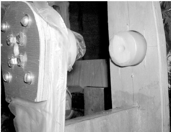
Mit PE-Folie geschützte Lagerrollen / Lagerrollenhalter vor dem Ausgießen des Spaltes mit Epoxidharz.
